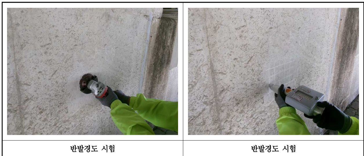
【사진 8.4.2】 반발경도시험 현장사진
