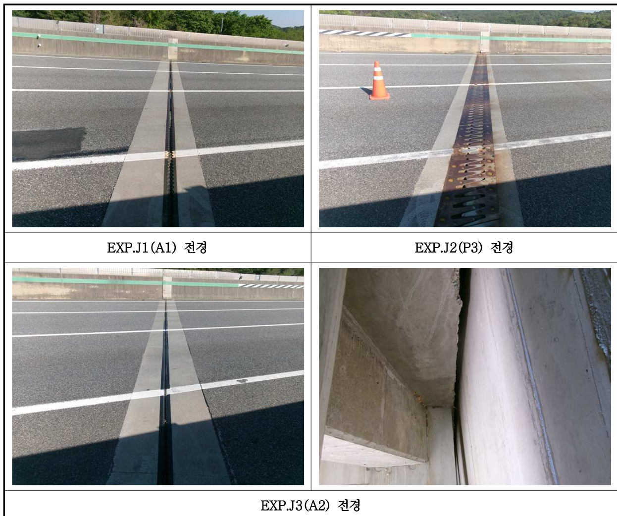
【사진 8.3.17】 신축이음장치 전경
