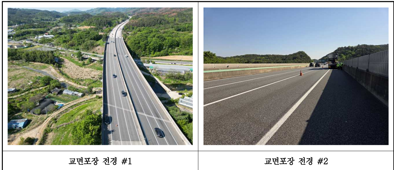
【사진 8.3.20】 교면포장 전경
