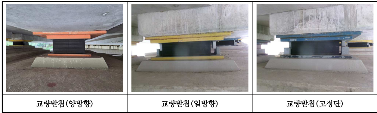
【사진 8.3.13】 교량받침 전경
