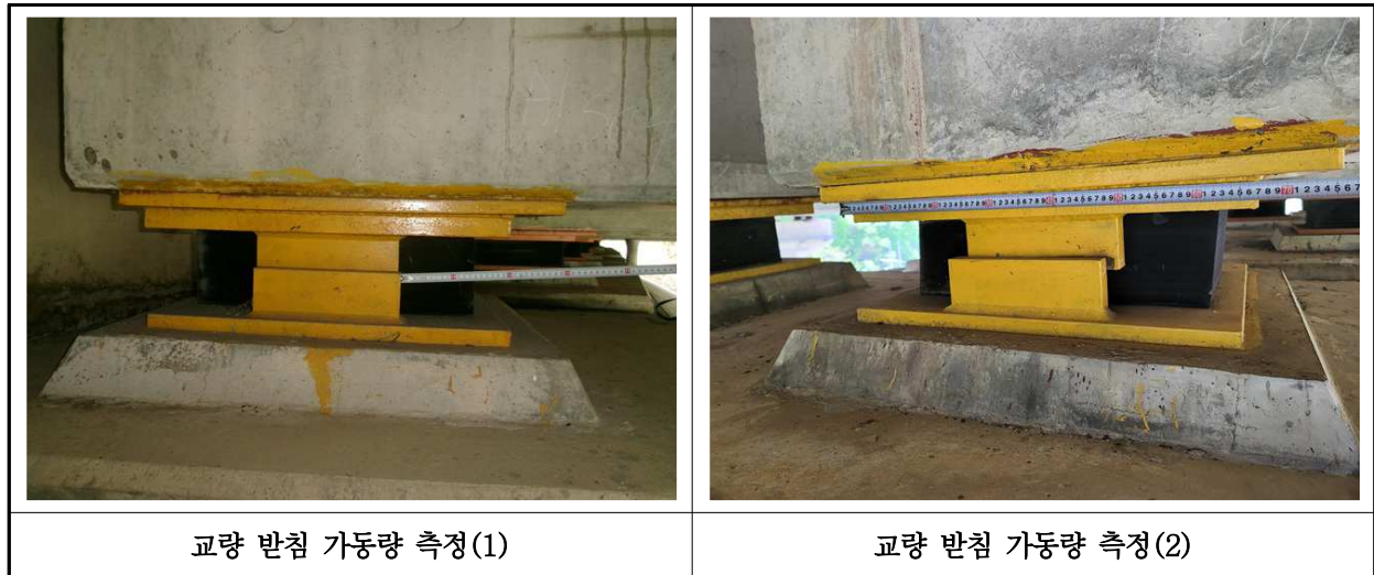
【사진 8.3.16】 교량받침 이동량 측정
