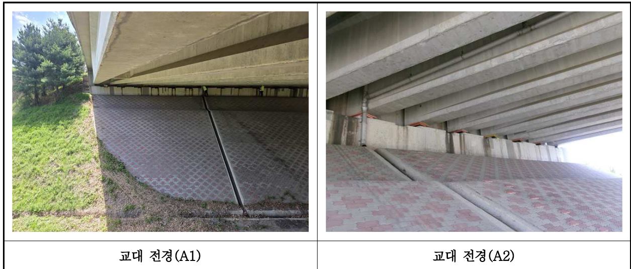
【사진 8.3.8】 교대 전경
